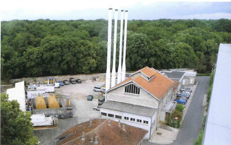
Équipements techniques de l'hôpital
