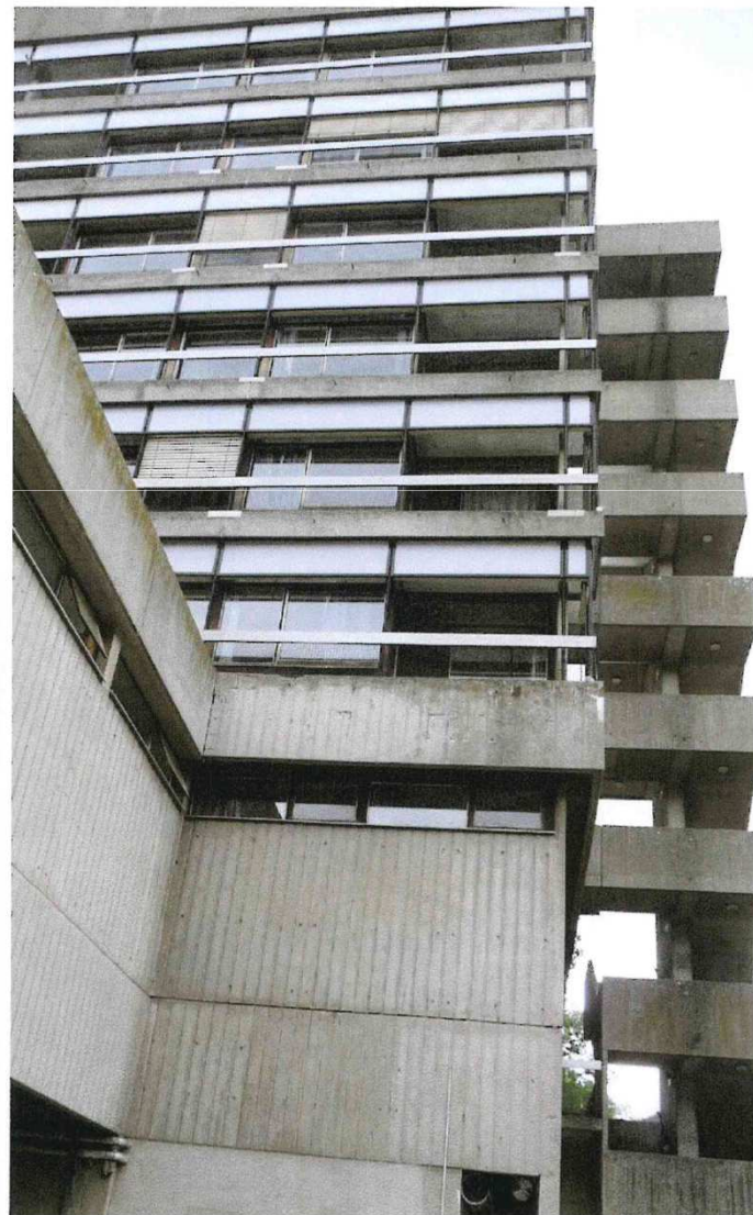
Bâtiment George Brassens 9 niveaux
