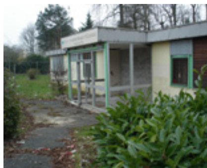
Démolition prochaine du Centre social Oberkirch et création d'un square
