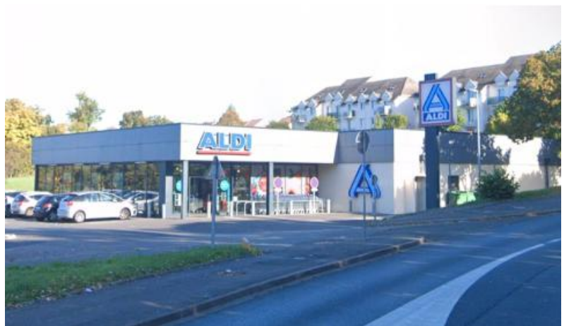
Des enseignes discrètes qui s'intègrent harmonieusement aux façades
