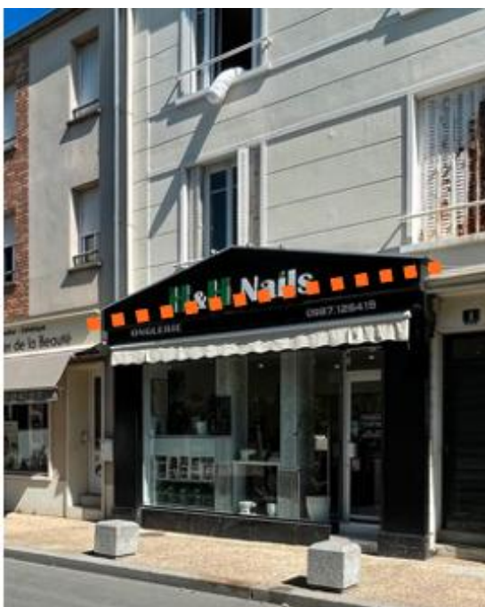
Implantation incohérente de l'enseigne sur une devanture qui ne respecte le cadre architectural du bâtiment
