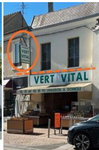
Enseignes perpendiculaires apposées sur bâtiment au-delà des limites du RDC où s'exerce l'activité
