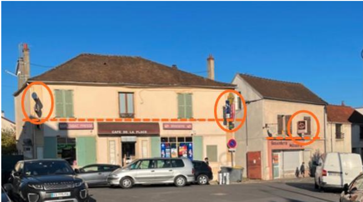
Enseignes perpendiculaires apposées sur bâtiment au-delà des limites du RDC où s'exerce l'activité
