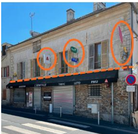
Enseignes perpendiculaires apposées sur bâtiment au-delà des limites du RDC où s'exerce l'activité
