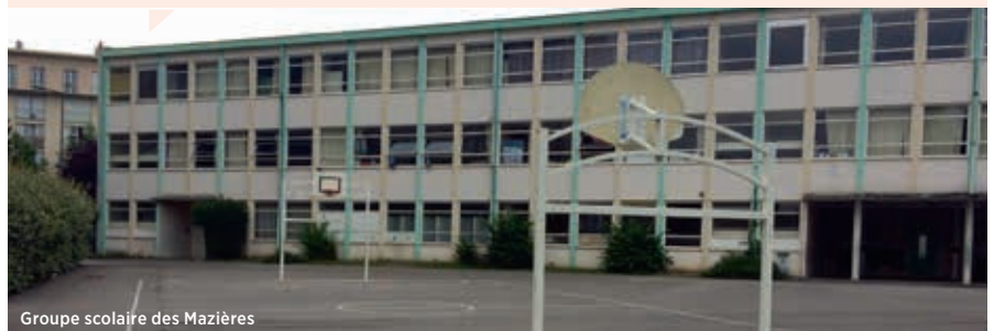
Groupe scolaire des Mazières
