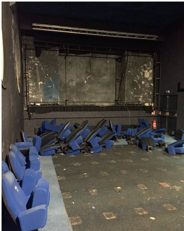
Une des salles à la reprise (état en mars 2021)
