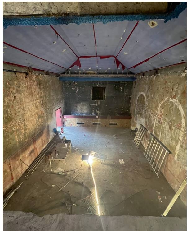
Curage du bâtiment (état début juillet 2023)
