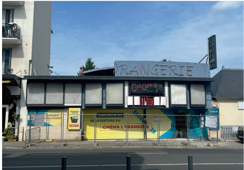
Démontage de l'enseigne (début juillet 2023)
