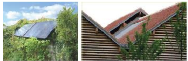
La pose de capteurs dans un espace végétalisé ou entre deux toits en limite l'impact visuel
