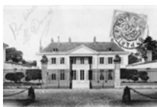
Château de Villiers
