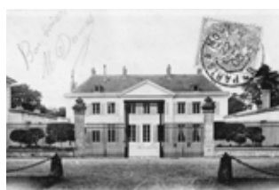
Château de Villiers
