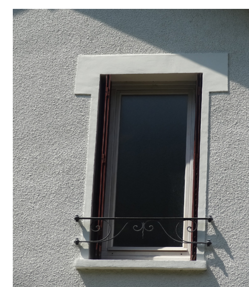
Linteau en ciment armé en surépaisseur
